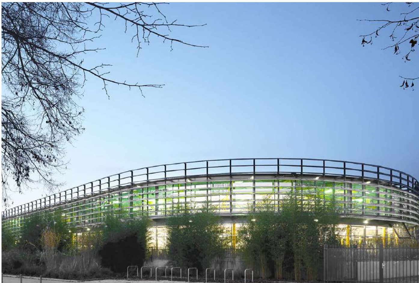
Lentpark, Köln, Deutschland. Architekturbüro: Schullitz Architekten, Elektroplanung: Ing.-Büro Heuchling ©Hoffmeister; Leuchte: 155
