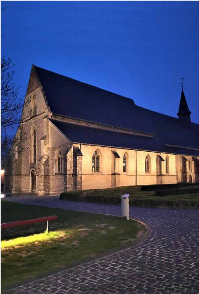
Begijnhofkerk, Sint-Truiden, Belgien. Leuchte: Hoffmeister - led.modular ©Hoffmeister
