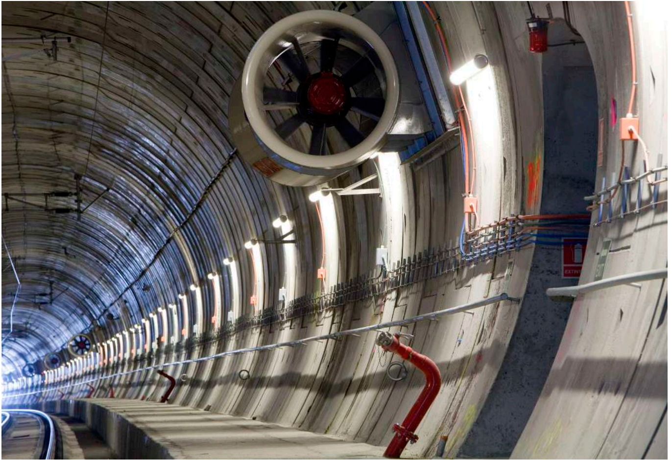
Perthus-Tunnel auf der Hochgeschwindigkeitsstrecke Frankreich – Spanien.
