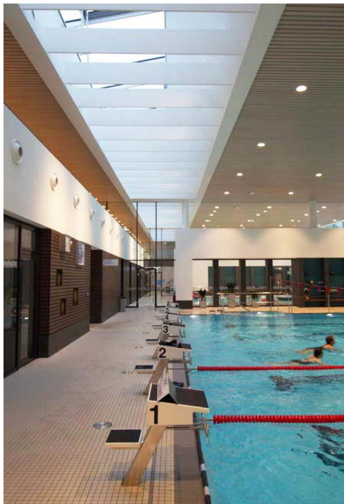
Piscine Fresh, Freising, Allemagne. Luminaire : complx.200. ©Hoffmeister
