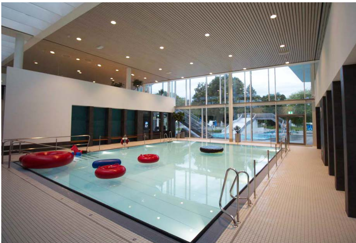
Piscine Fresh, Freising, Allemagne. Luminaire : complx.200. ©Hoffmeister
