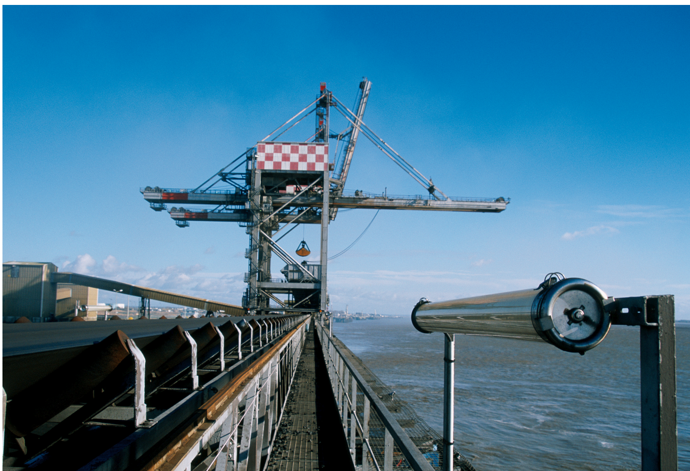
Port de Nantes Saint-Nazaire, convoyeur de charbon
