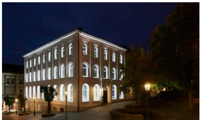
Durch die Betonung von Fensterrahmen erhalten Gebäude bei Nacht eine eigenständige Nachtarchitektur. Dank der sehr engstrahlenden Lichttechnik ist bei dieser Art der Beleuchtung auch Blendung im Gebäude, aber auch außerhalb des Gebäudes nahezu ausgeschlossen.
