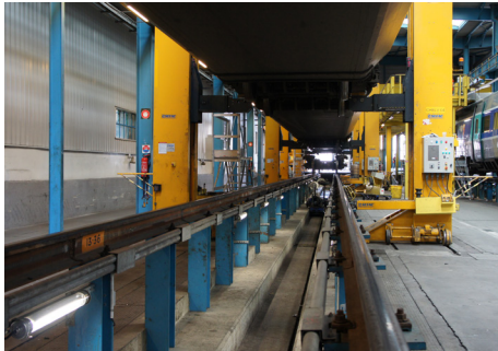
Maintenance pit - Niepce FV
