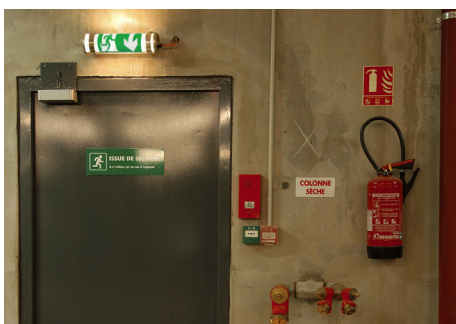
Notbeleuchtung – COULOMB autonomer Notbeleuchtungsblock
