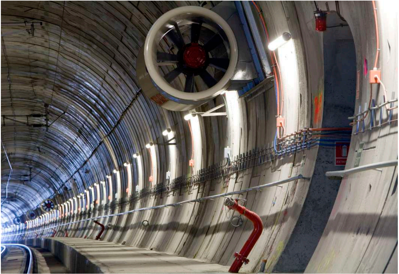
Tunnel LGV du Perthus, France, Espagne.
