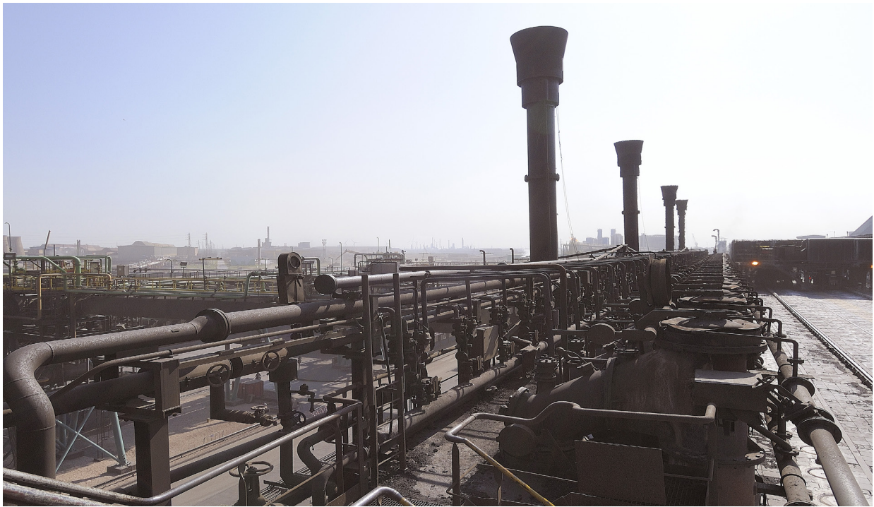
Aciérie ArcelorMittal, Dunkerque, France.
